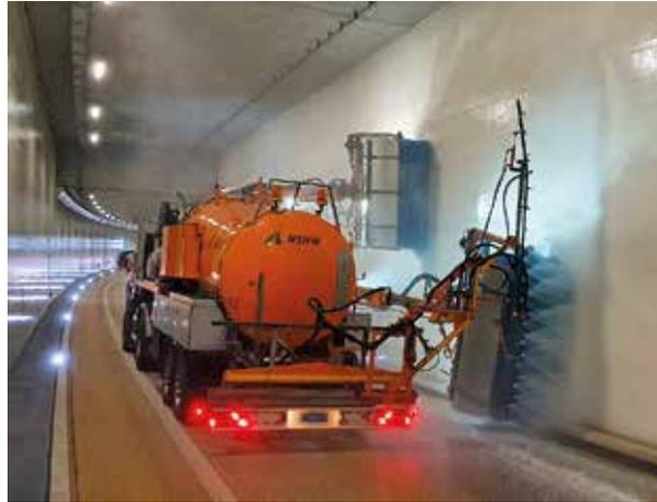
Eine periodische **Reinigung** von Tunneln, Entwässerung und anderen Anlagen optimiert deren Betriebssicherheit und Betriebsbereitschaft. Saubere Strassen können sorgenfrei befahren werden und helle Tunnelwände verringern die Unfallgefahr.
